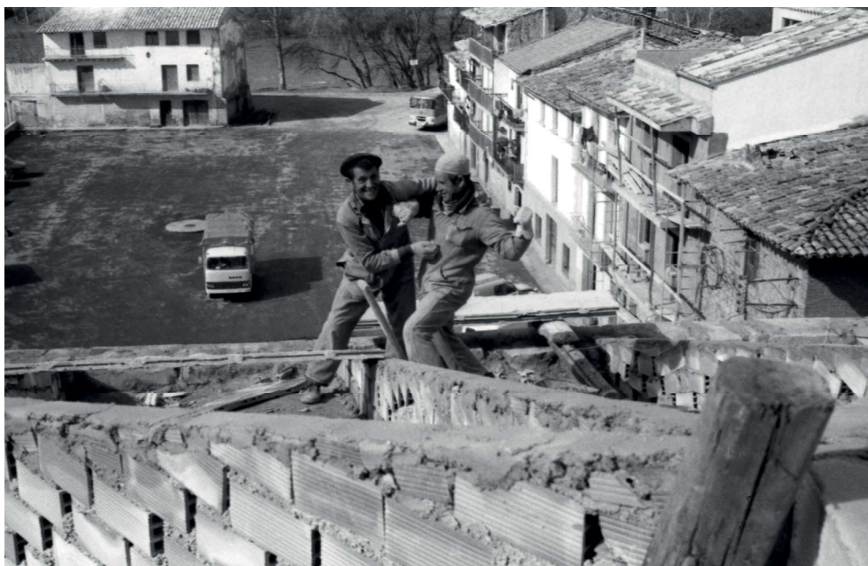
Arreglando el tejado de San Salvador.
