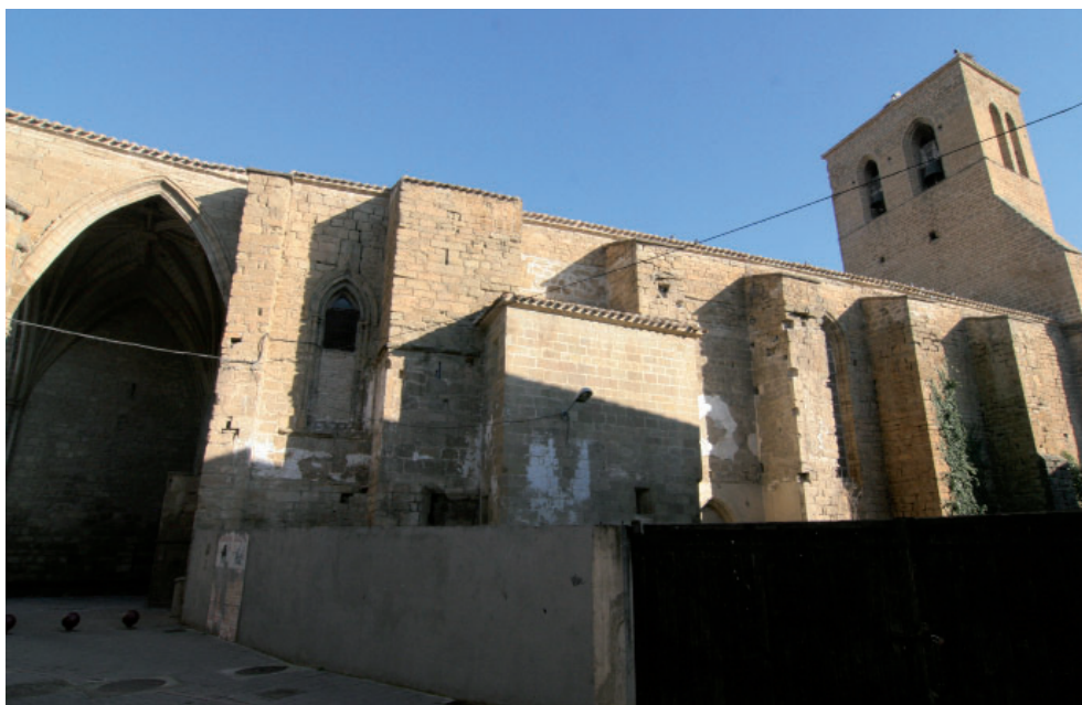
Iglesia de San Salvador. Vista desde el sur.
