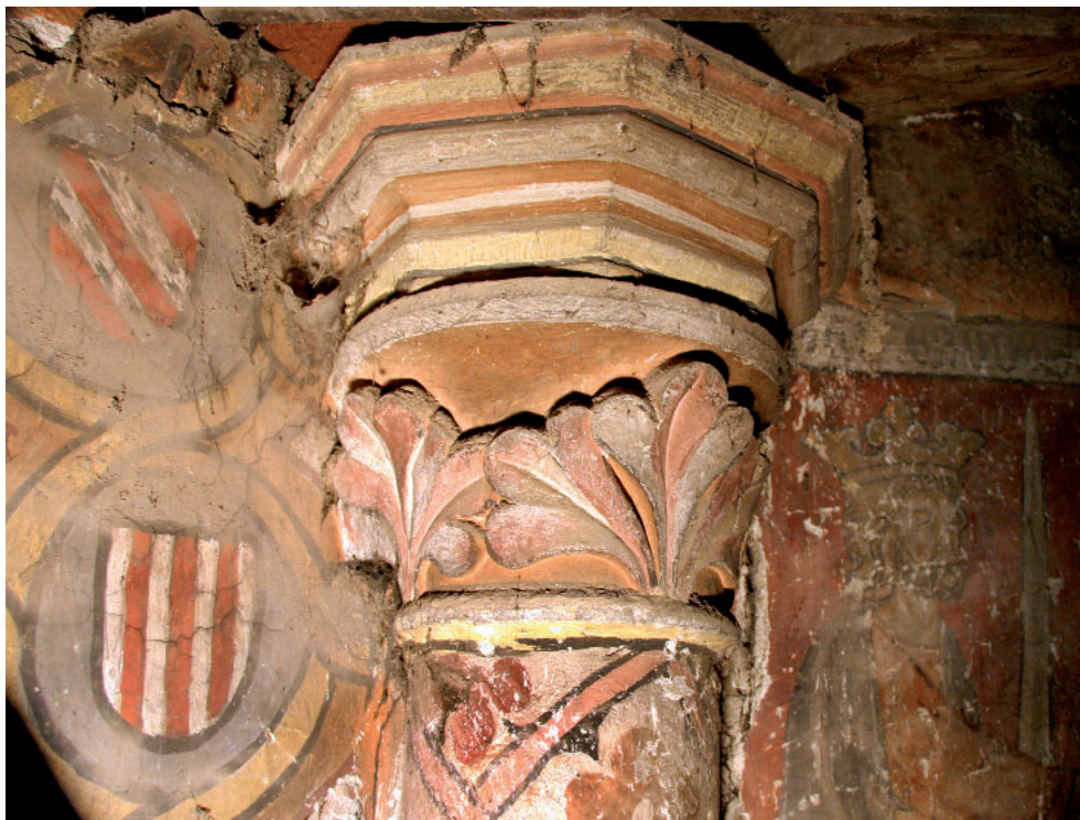
Iglesia de San Salvador. Pinturas presbiterio. Capitel y columna.
