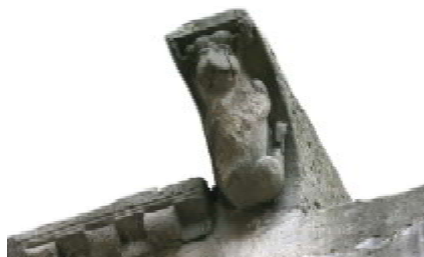
Fig. 33.- Canecillo nº 2. Cámara de Comptos
