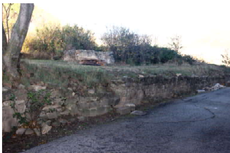
Fig 3.- Murete de contención con piezas reutilizadas
