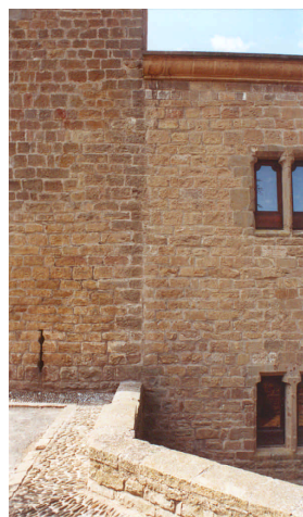
Unión de la torre este y el cuerpo residencial. Se aprecia la falta de trabazón de sus muros.
