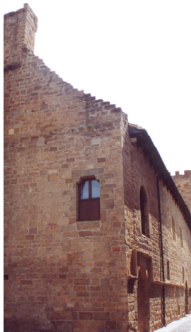
Puerta de acceso a una desaparecida ala norte.
