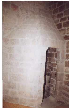
Final de la escalera en el tercer piso
