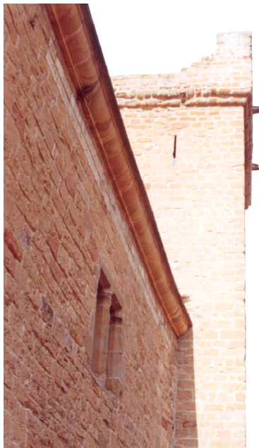
Cuerpo residencial, con la restaurada cornisa. Arriba, una aspillera de flanqueo, para dominar el antiguo paseo de ronda. Seguramente había otra saetera en el primer piso, pero fue ocultada al edificar el edificio palaciego
