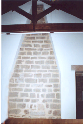
Chimenea situada en la segunda planta. En ella se calentaron los últimos reyes de Navarra, Juan de Albret y Catalina de Foix, en los últimos años del reino pirenaico. A la derecha, puerta de acceso a la torre oriental.
