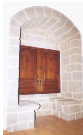
Ventana «cortejadora» dotada con dos asientos o «poyos» que aprovechan el ancho del muro.
