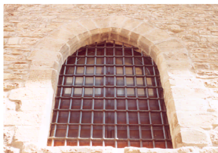
Antigua puerta alta, probable acceso a una galería o balcón situado en el frente sur.
