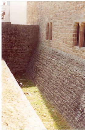
Foso con su contrasescarpa en talud, revestida de sillares.
