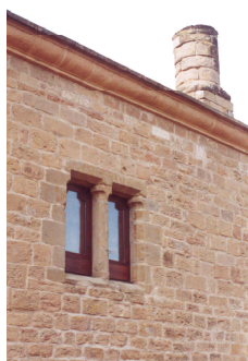
En la actualidad se conservan cuatro chimeneas de las que dos de ellas tienen salida al exterior.
