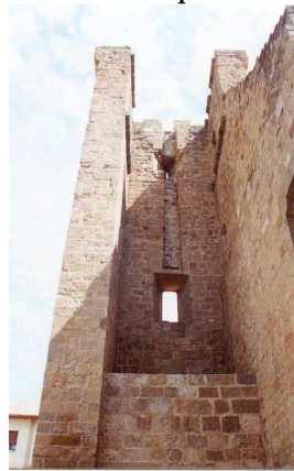
Interior de la torre
