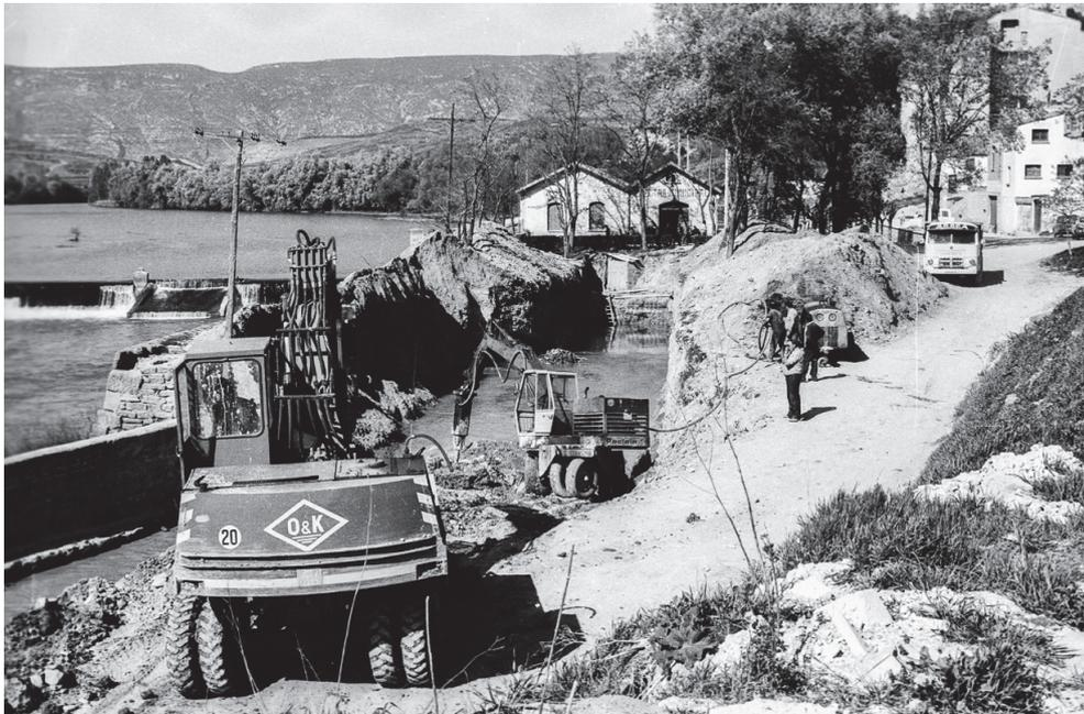
*Haciendo el túnel para la salida del agua de las máquinas de la central hidroeléctrica, en 1985.*
