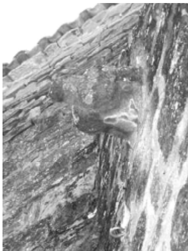
La molindanga buitre o águila petrea en un contrafuerte de pared norte de la parroquia de Rocaforte, motivo de la leyenda y del apedreamiento de los chicos de hoy y del pasado. Fotografía David Maruri, 30.06.2012.
