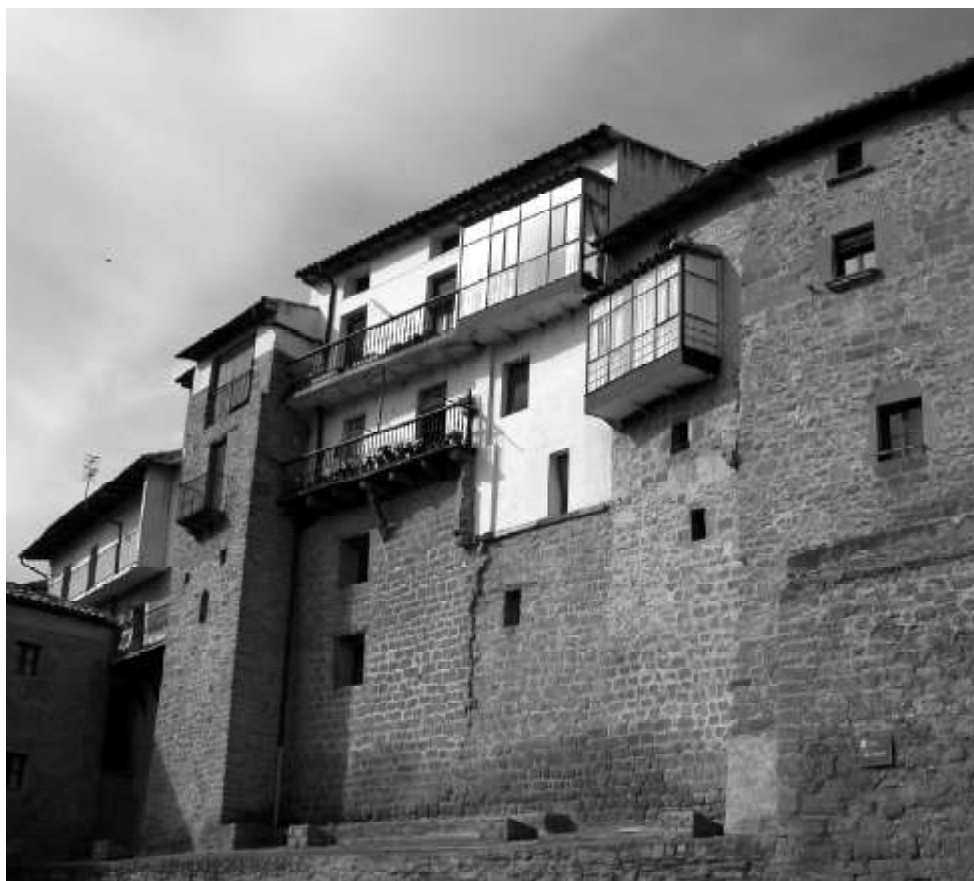
Lienzo de muralla construido en sillarejo y torreón de planta cuadrada con la base de los muros en talud.
