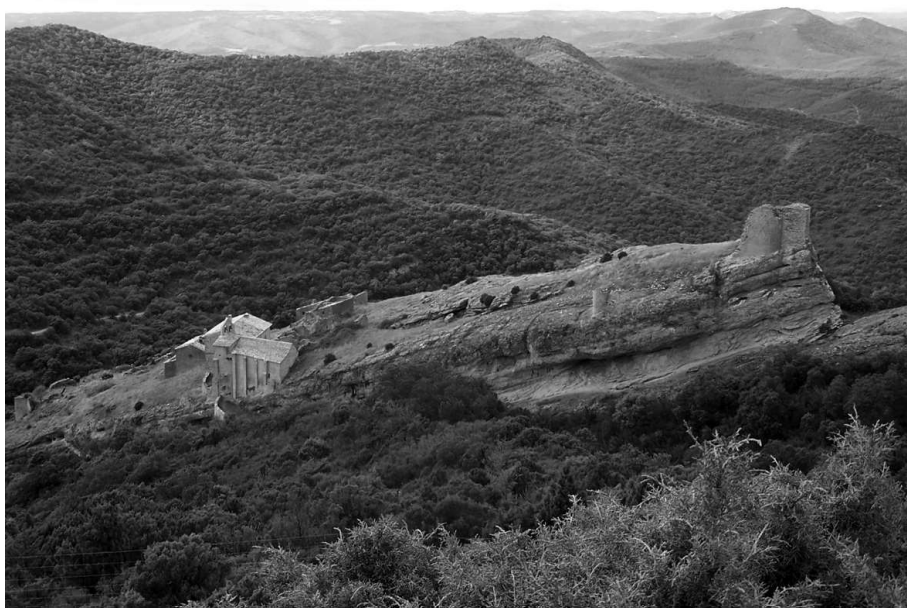
Panorámica del castillo y despoblado de Peña desde la década de los sesenta del pasado siglo, sobre el roquedo de orientación N-S, meseta inclinada, cortada por el N, E y O y protegida en el S por una gran muralla hoy en ruinas. Fotografía: David Maruri. 29.10.2008
