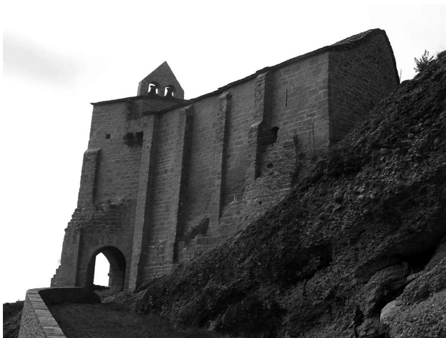
Iglesia de San Martín de Peña, monumento importante del recinto defensivo y uno de los dos portales o pasadizo de acceso y salida del poblado. Fotografía: David Maruri. 29.10.2008
