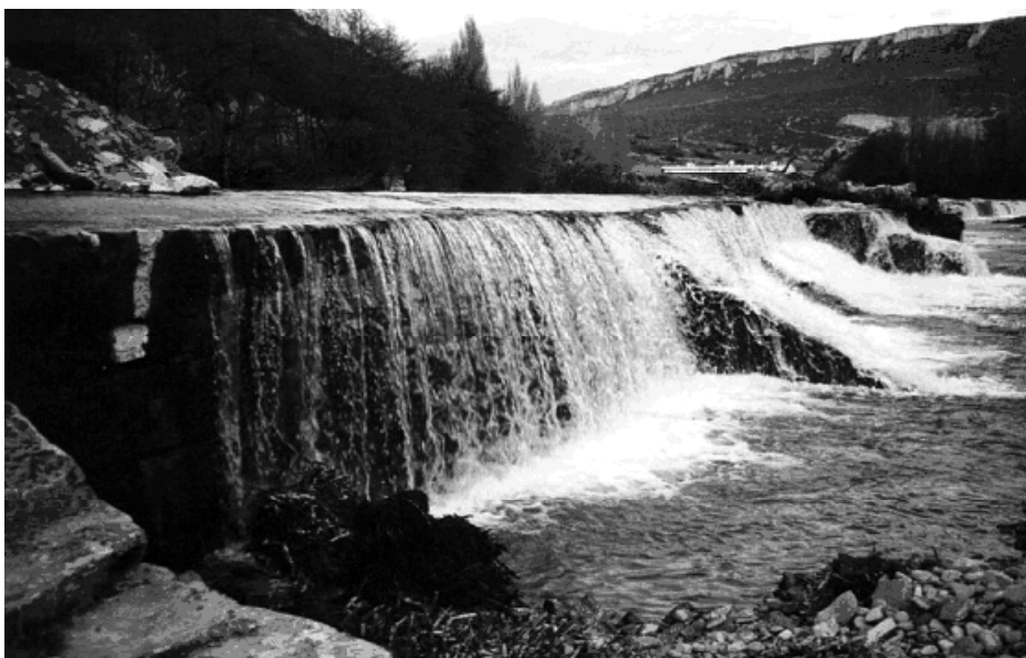
Presa del río Irati entre Liédena y Sangüesa.
