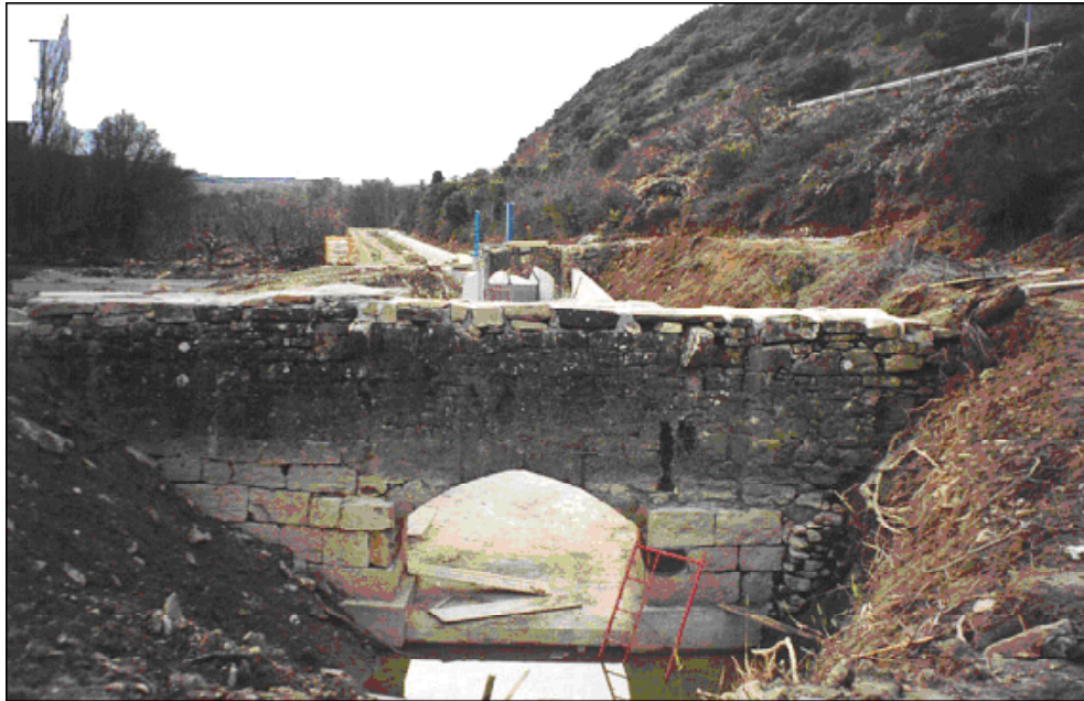
Portillos de la acequia junto a la presa en pleno proceso de restauración. Año 2001.
