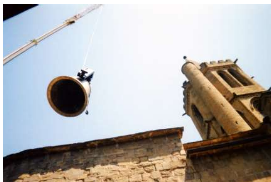
La campana se sube a la torre
